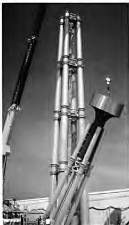
I dati di progetto cui tale struttura doveva rispondere (soprattutto il contenimento delle oscillazioni in sommità e dei cicli di fatica indotte dalla rotazione delle apparecchiature radar) hanno presto evidenziato anche la necessità di ricorrere ad una geometria tronco-piramidale.
